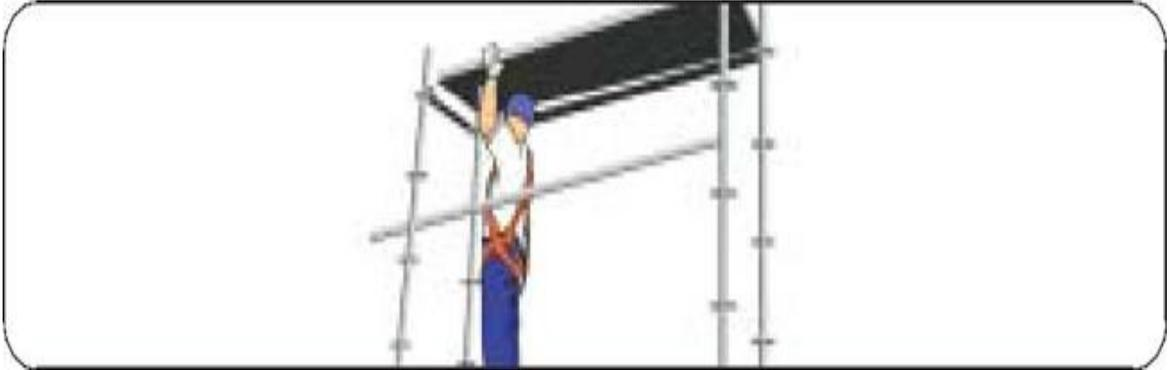
**Figura 26.** Instalación de plataformas y módulo de escaleras.
