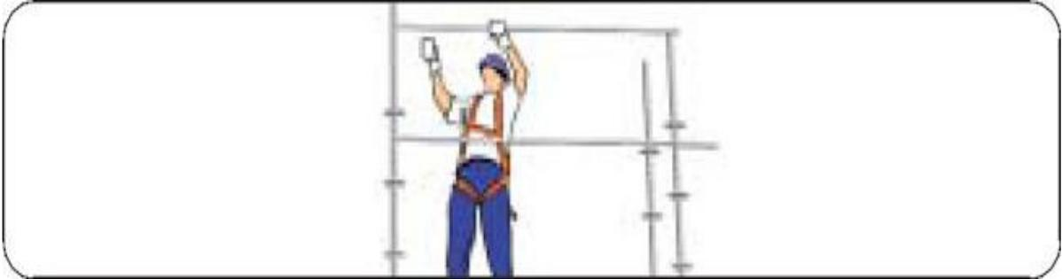
**Figura 35.** Desmontaje de amarres
