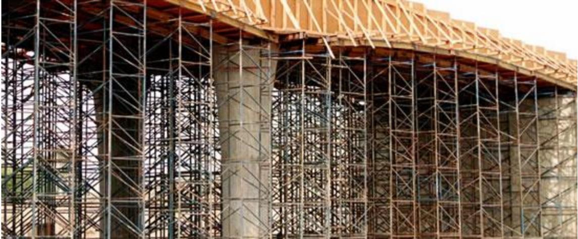
**Figura 5.** Andamiaje tubular bajo puente. Obtenido de:
