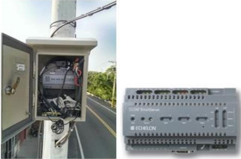
**Figura 25.** Instalación módulo de control de conjunto de luminarias. (Billion) (Businesswire)
