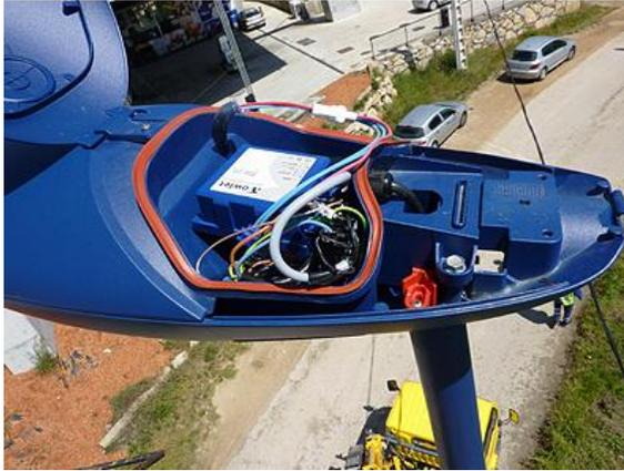
**Figura 24.** Instalación módulo de control de luminaria. (Construnario)
