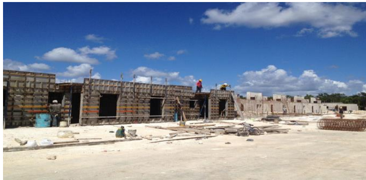
Formaletas metálicas para la construcción de vivienda industrializada.
