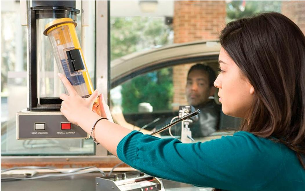
*Ilustración 37: Tubo neumático y cristal de autobanco*
