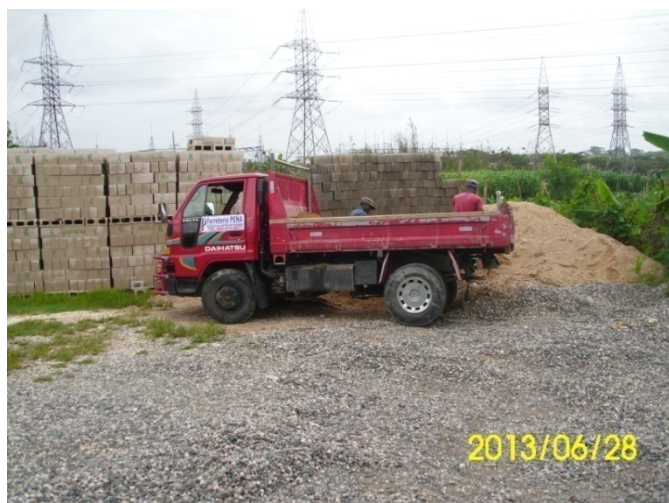
Figura 11: Solar que se utiliza como depósito principal de materiales de construcción
