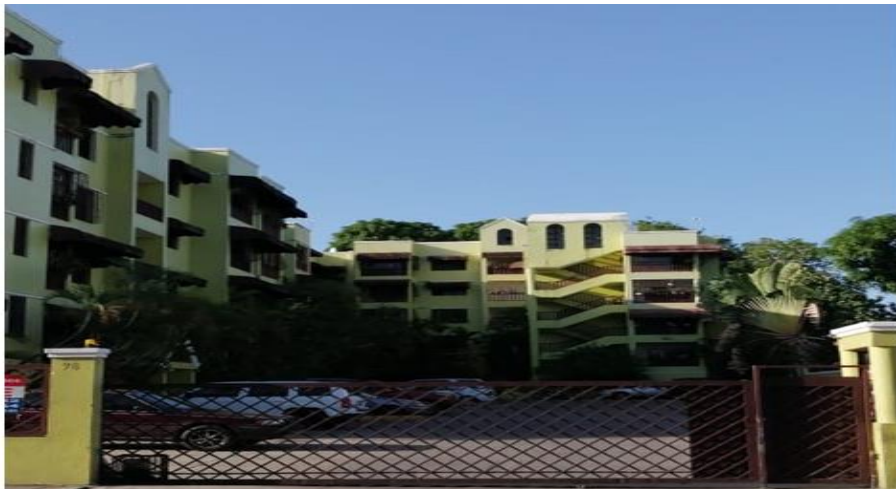
Figura 2: Residencial G18, espacio de las cisternas.
