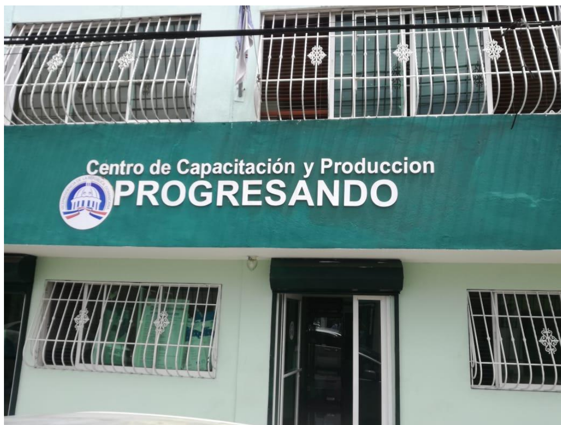
Fachada CCPP donde opera el Aula Inclusiva de Capotillo.
