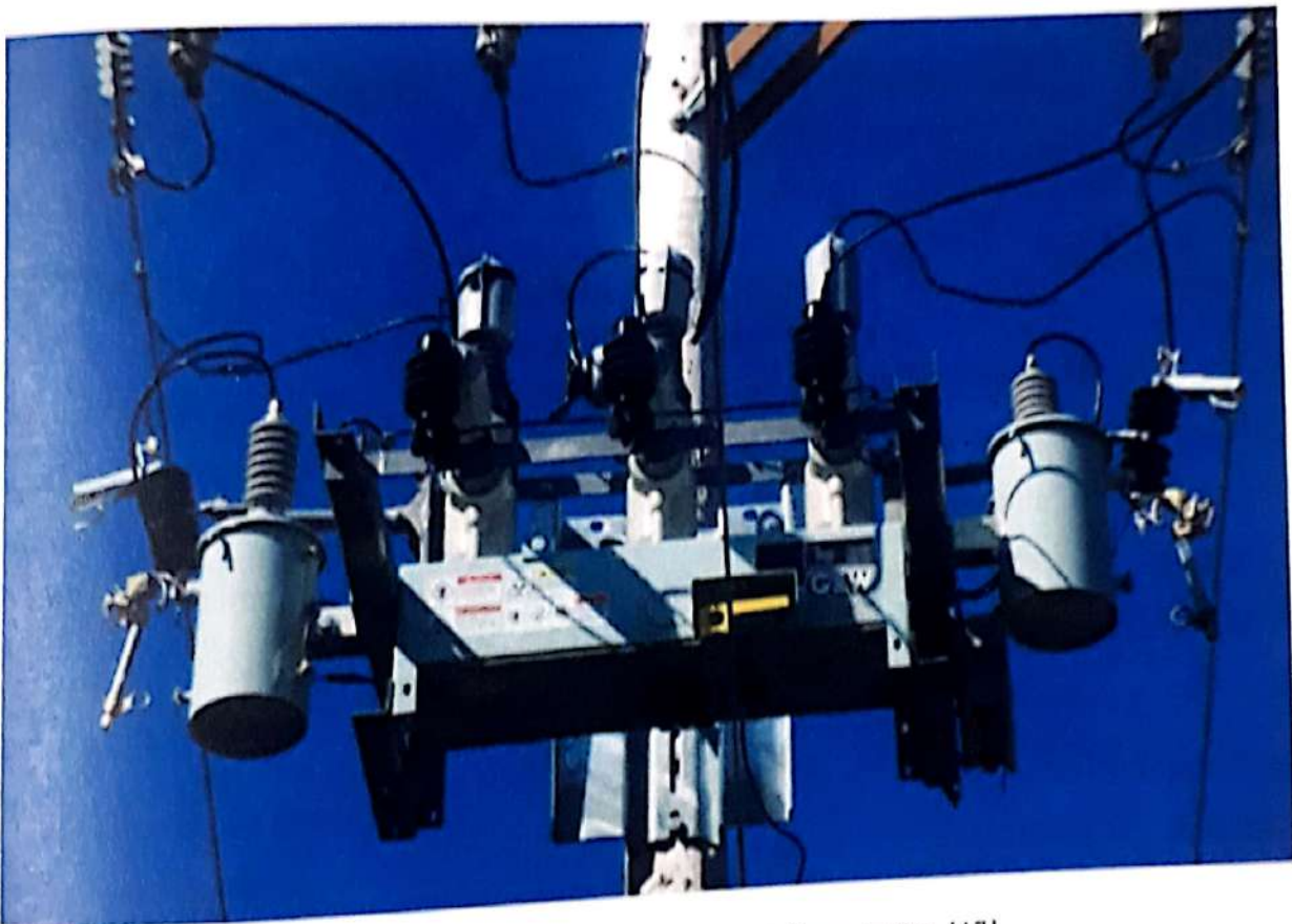
Figura 3-22: Recierre en Vacío Relleno de Gas. [17]
