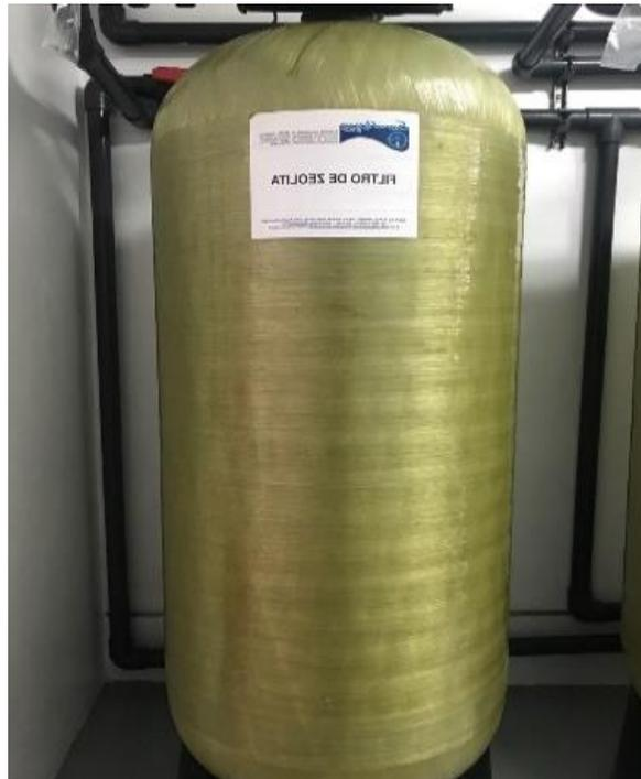
*Ilustración 10. Filtro de zeolita*
