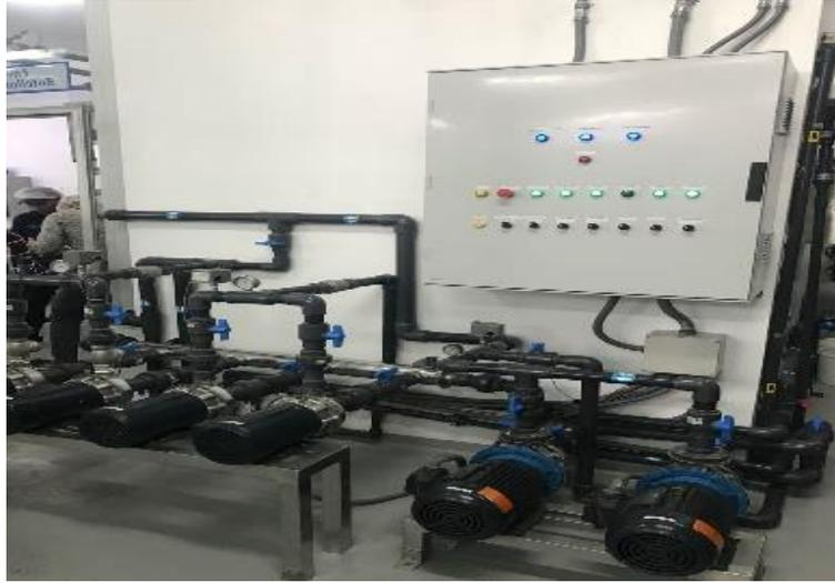
*Ilustración 11. Controles para transporte del agua al filtro ultravioleta*
