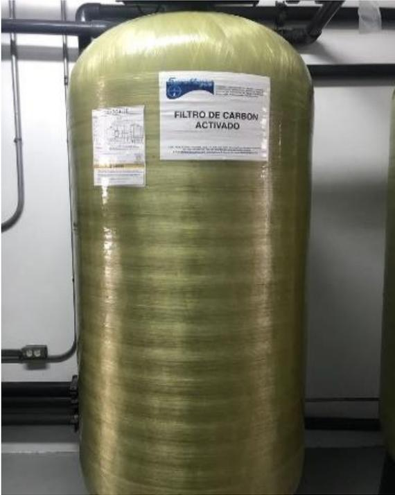
*Ilustración 8. Filtro de carbón activado*
