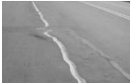
*Figura 25: Ondulaciones en el pavimento.*
