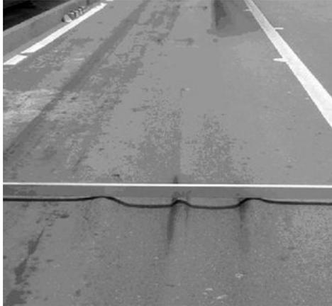
Figura 23: Ahuellamiento en una ruta asfáltica.
