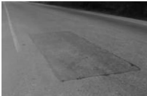
*Figura 21: Parches deteriorados en la Calle 38, Cristo Rey.*
