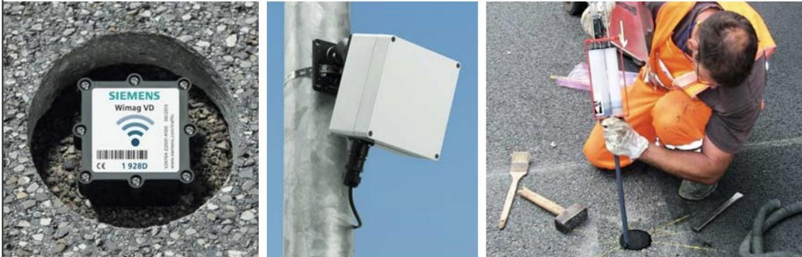
**Figura 4.5** Componentes y proceso de instalación de los sensores. **Fuente:** Siemens
