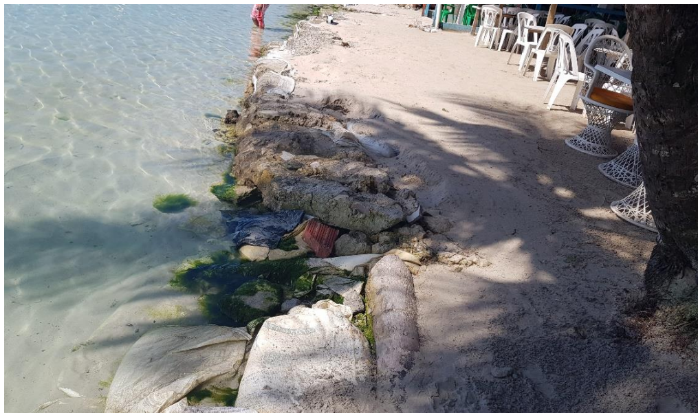
Imagen 11: Tubería semi visible restaurante D´ Sony Bar
