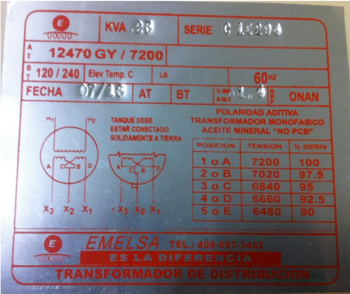
Figura 37: Placa de especificaciones de transformador de 25 KVA
