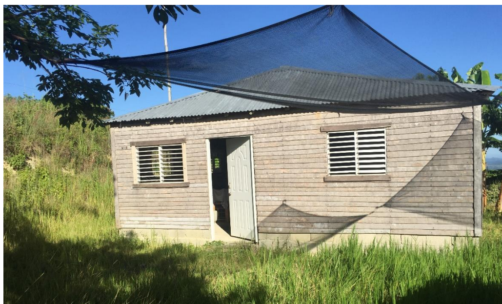
Figura 44: Fachada de vivienda en la comunidad La Descubierta
