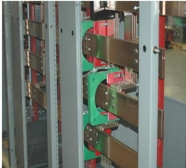
**Figura 31.** Transformadores de corriente (CT) instalados en barras alimentadoras. (Fundamentals of Paralleling, Cummins Power Generation, 2013)
