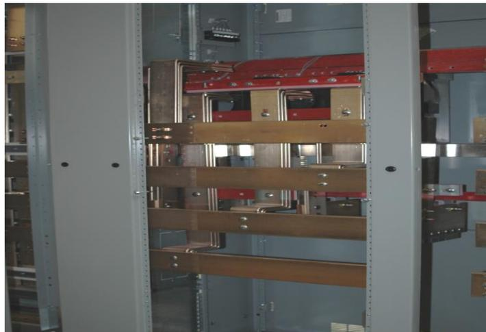
**Figura 25.** Arreglo de barras horizontal “Cross Bus” Switchgear en Cummins Power Generation ubicado en Fridley (Fundamentals of Paralleling, Cummins Power Generation, 2013).
