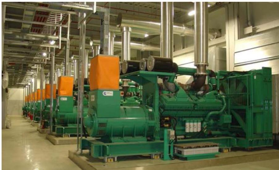
**Figura 23.** Grupos generadores conectados a una barra común, simultáneamente alimentando una carga común (T-016 Paralleling Application Manual, Cummins Power Generation, 2014)
