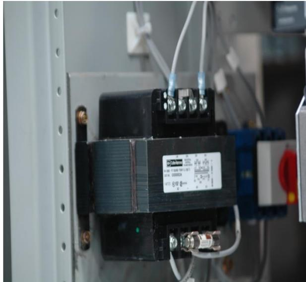
**Figura 29.** Fusible montado en un CPT (Fundamentals of Paralleling, Cummins Power Generation, 2013)
