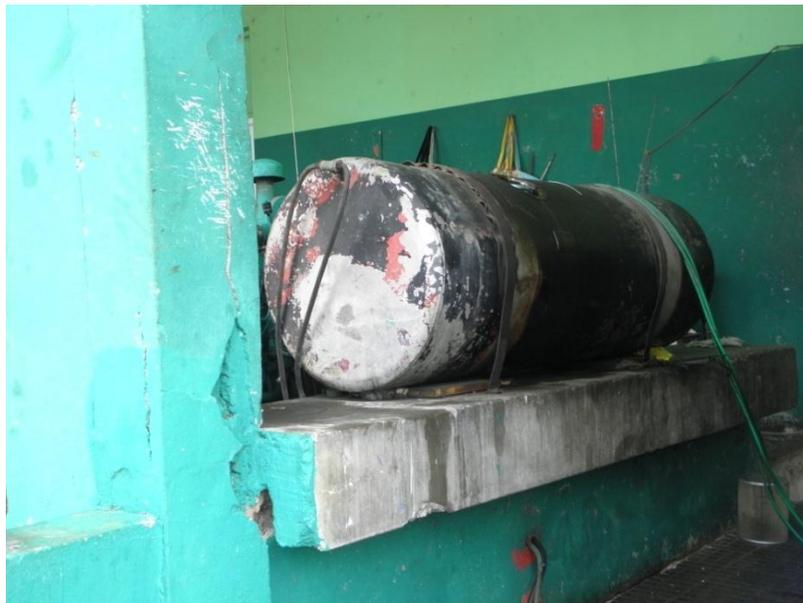
**Figura 45.** Tanque de combustible de la planta eléctrica.
