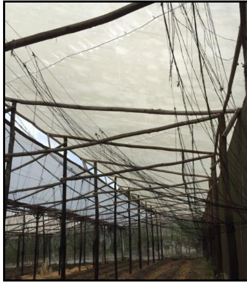
Figura 16. Techo en mallas del Invernadero de la Cruz
