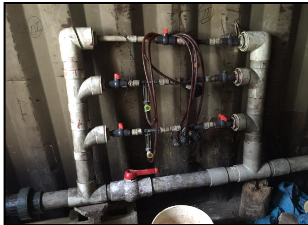
Figura 19. Válvulas para el control de riego en el Invernadero de la Cruz Fuente: Invernadero de la Cruz
