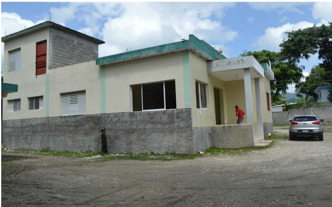
Instalaciones del Clúster de Aguacate. Cambita, San Cristóbal.
