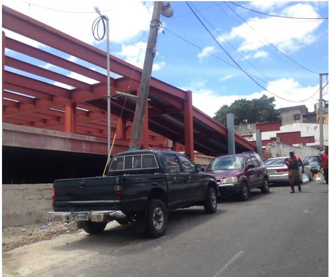
Figura 10: Imagen construcción parqueo Atarazana.
