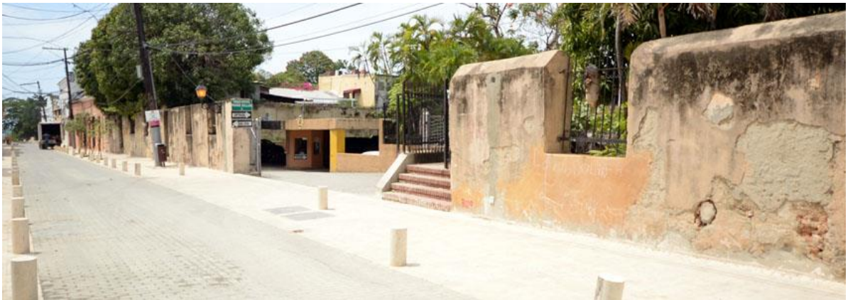
Figura 7: Imagen entrada Parqueo Municipal Padre Billini.
